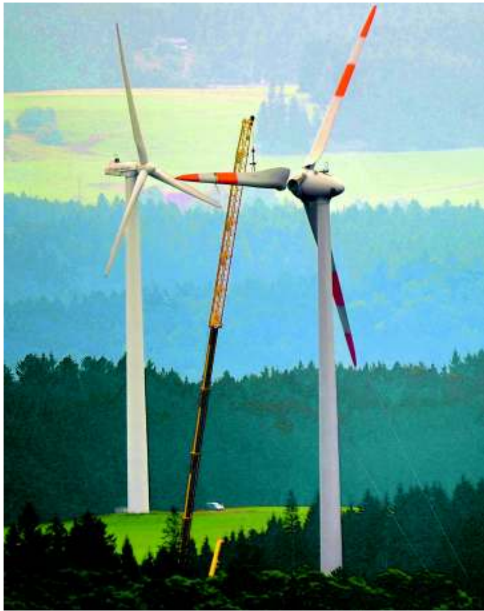
Bei St. Peter im Hochschwarzwald bläst der Wind. Im Juli wurden hier die Rotorblätter zweier Windräder mit Hilfe eines Krans ausgetauscht. Foto: dpa
